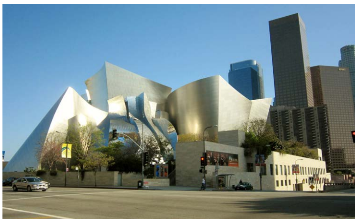
Εικ.11.37 F.O.Gehry, Walt Disney Concert Hall , 2003, Λος Άντζελες, φωτ. Β.Πετρίδου.
