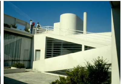
Εικ.9.64 Le Corbusier, Villa Savoye (1928-1931), εσωτερικό, Poissy-sur-Seine, φωτ. Β.Πετρίδου.
