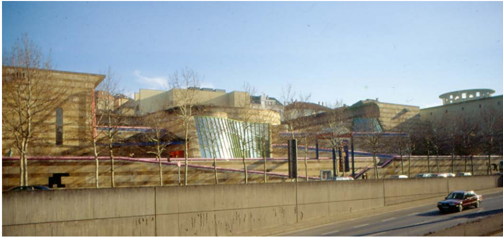
Εικ.10.112 J. Stirling, M. Wilford, Νέα πτέρυγα της Εθνικής Πινακοθήκης, 1977-1983, Στουτγάρδη, φωτ. Β.Πετρίδου.
