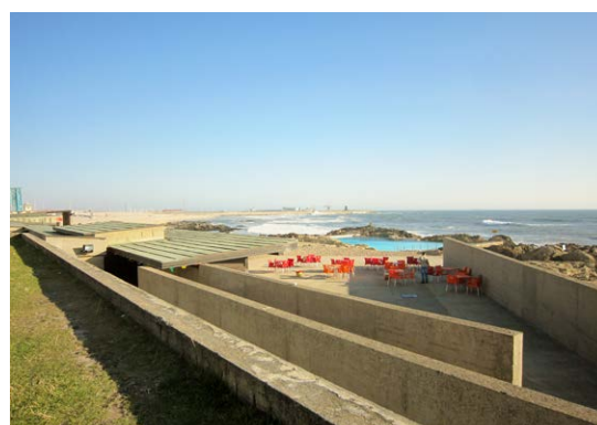
Εικ.10.58 A. Siza Vieira, εξωτερικές πισίνες Leça de Palmeira, 1966, Portugal, φωτ. Β.Πετρίδου.
