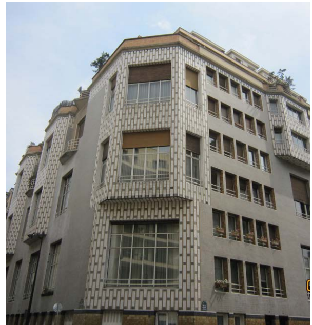
Εικ.6.64 H. Sauvage, κτίριο κατοικιών, στην οδό de la Fontaine, 1926-1928, Παρίσι, φωτ. Β.Πετρίδου.
