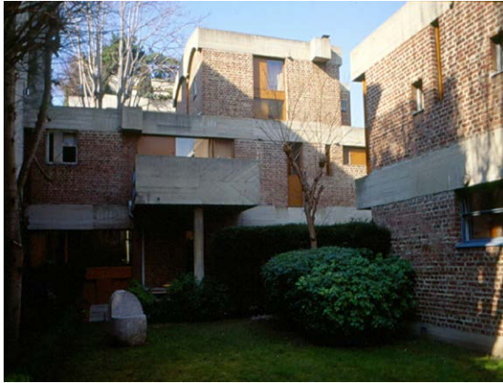
Εικ.9.73 Le Corbusier, Maisons Jaoul, Neuilly-sur-Seine, France, 1951, φωτ. Β.Πετρίδου.
