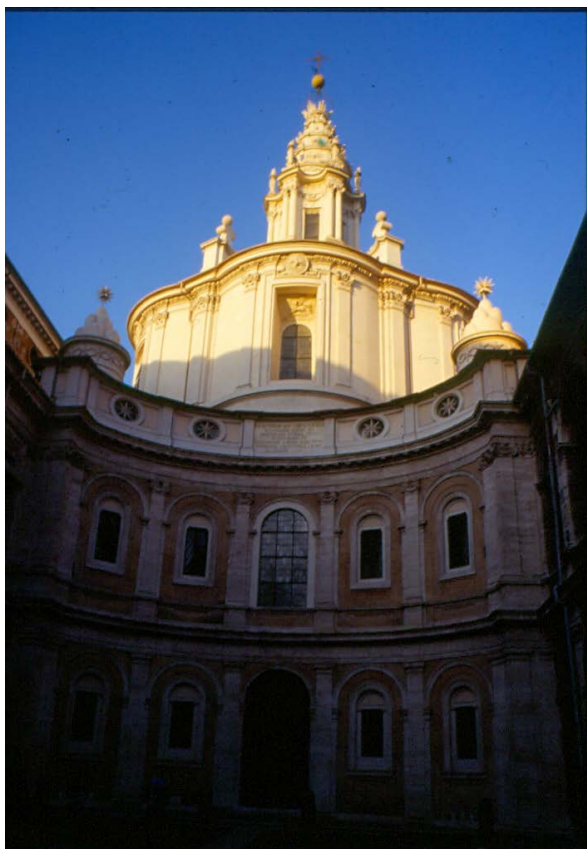
Εικ.2.13 F.Borromini, Παρεκκλήσιο Sant' Ivo alla Sapienza, 1642-1662, Ρώμη, φωτ. Β.Πετρίδου.
