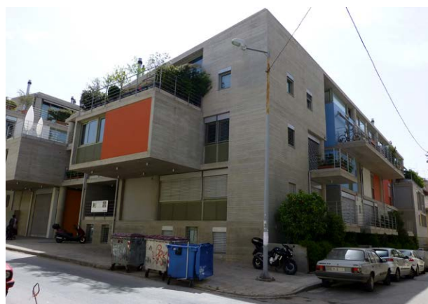
Εικ.11.119 Γ. Δασκαλάκη, Γ. Παπαδόπουλος, Συγκρότημα κατοικιών και καταστημάτων, Μεταξουργείο, 2009, Αθήνα, φωτ. Β.Πετρίδου.
