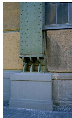
Εικ.6.59 P. Behrens, Εργοστάσιο τουρμπινών AEG (Allgemeine Elektrizitäts-Gesellschaft), 1909, λεπτομέρεια μεταλλικού κίονα, Βερολίνο, φωτ. Β.Πετρίδου.
