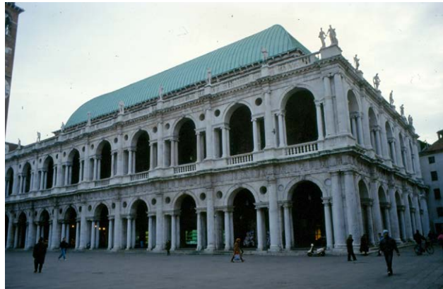
Εικ.1.63 A. Palladio, Basilica, 1546-1549, Βιτζέντζα. φωτ. Β. Πετρίδου.
