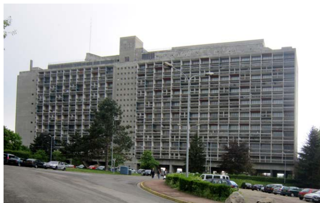
Εικ.10.47 Le Corbusier, Unité d'Habitation , Firminy, 1964, Γαλλία, φωτ. Β.Πετρίδου.
