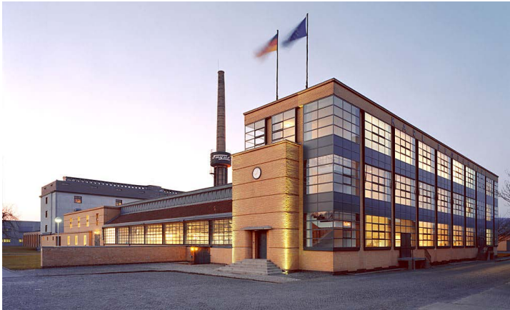
Εικ.9.43 W. Gropius, A. Meyer, Faguswerk, Alfeld an der Leine, 1910–1911. Πηγή: https://en.wikipedia.org/wiki/Fagus_Factory .
