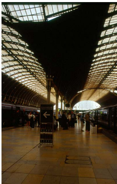
Εικ.5.7 Σιδηροδρομικός σταθμός Πάτινγκτον, 1854, Λονδίνο, φωτ. Β.Πετρίδου.
