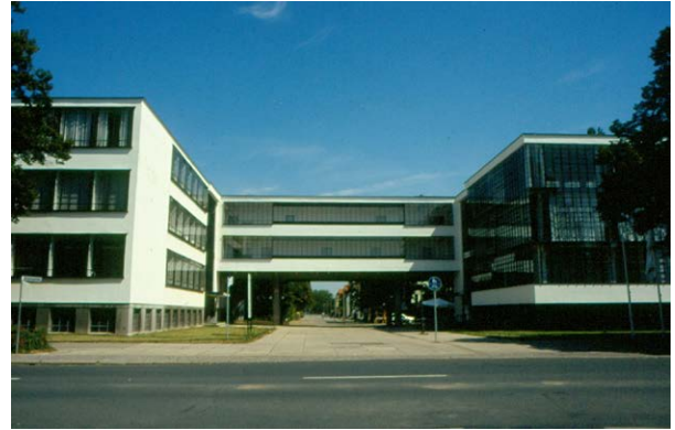
Εικ.9.17 W. Gropius, Σχολή Bauhaus, 1925-1926, Dessau, φωτ. Β.Πετρίδου.
