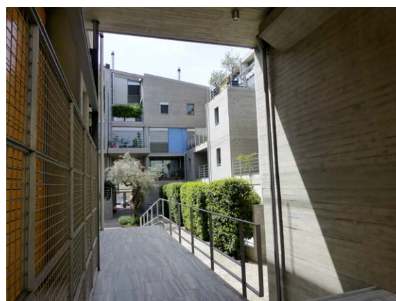
Εικ.11.120 Γ. Δασκαλάκη, Γ. Παπαδόπουλος, Συγκρότημα κατοικιών και καταστημάτων, Μεταξουργείο, 2009, Αθήνα, φωτ. Β.Πετρίδου.
