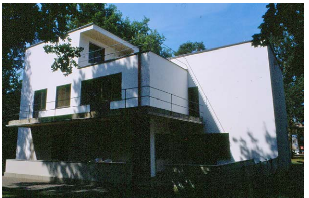
Εικ.9.21 W. Gropius, κατοικίες καθηγητών της Σχολής Bauhaus, 1925-1926, Dessau, φωτ. Β.Πετρίδου.
