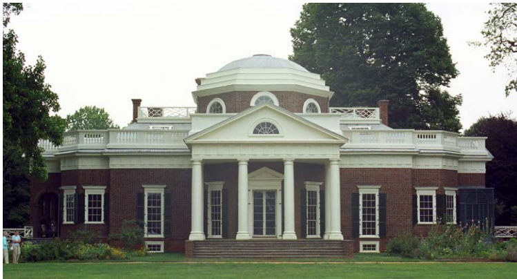
Εικ.3.32 Th. Jefferson, η κατοικία του στο Μοντιτσέλο της Βιρτζίνια, 1796-1806. Πηγή: https://en.wikipedia.org/wiki/Thomas_Jefferson .
