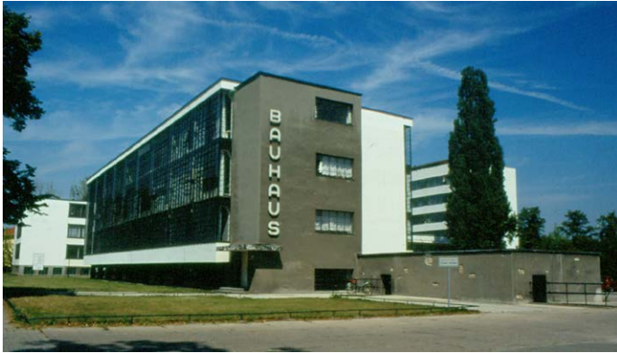
Εικ.9.16 W. Gropius, Σχολή Bauhaus, 1925-1926, Dessau, φωτ. Β.Πετρίδου.
