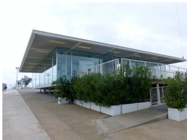
Εικ.11.122 Α.Π. Μουρελάτος, Σ. Γιωτάκης, Κέντρο Υποδοχής Επισκεπτών, Κέντρο Πολιτισμού, Ίδρυμα Σταύρος Νιάρχος, 2013, Αθήνα, φωτ. Β.Πετρίδου.
