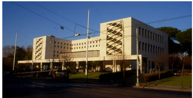
Εικ.9.93 A.Libera, M.De Renzi, Palazzo delle Poste all' Aventino , 1933, Ρώμη, φωτ. Β.Πετρίδου.
