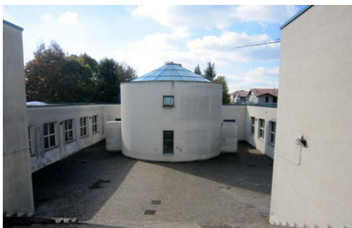
Εικ.10.92 A. Rossi, Σχολείο Fagnano Olona, 1972, φωτ. Β.Πετρίδου.
