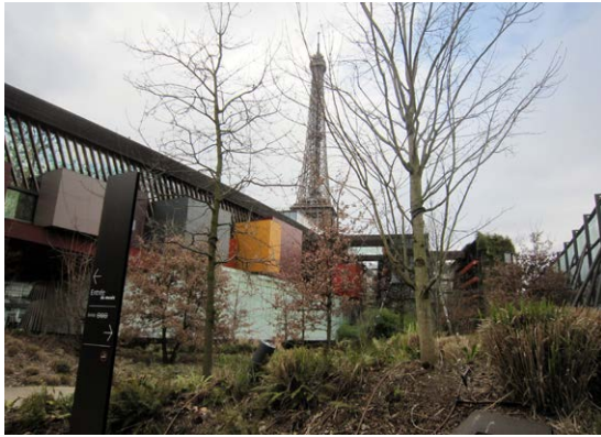
Εικ.11.55 J.Nouvel, Μουσείο Du Quai Branly, 2006, Παρίσι, φωτ. Β.Πετρίδου.
